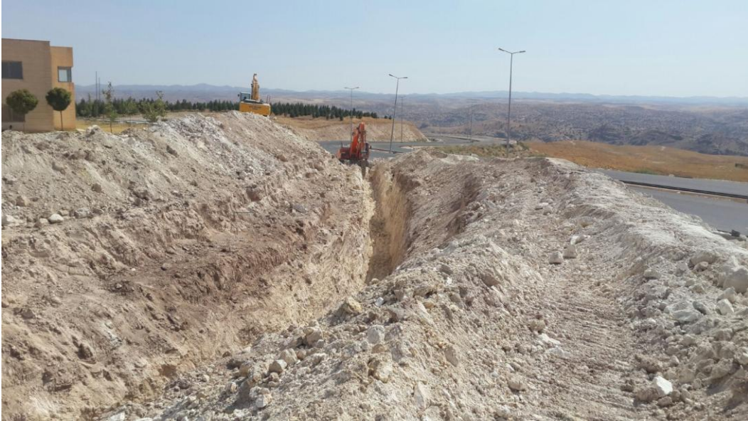
Sıhhi Tesisat Onarım
