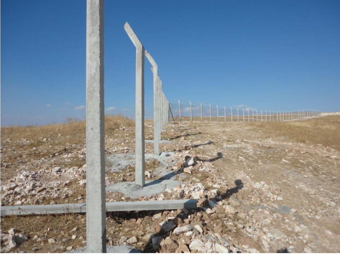
Beton Direkli Kafes Tel ve Helezonlu Jiletli Tel ile it Yapım İŐi
