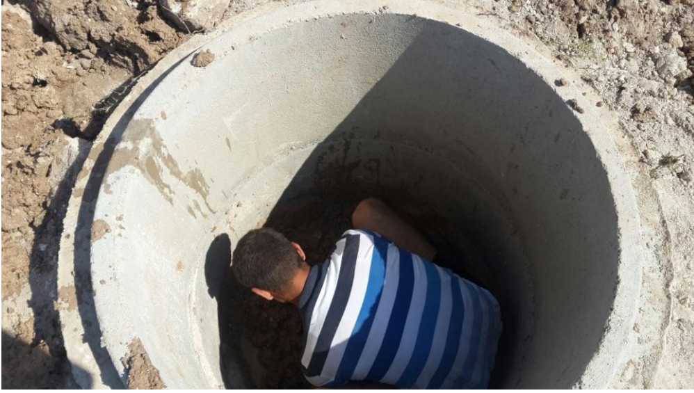
Sıhhi tesisat onarım
